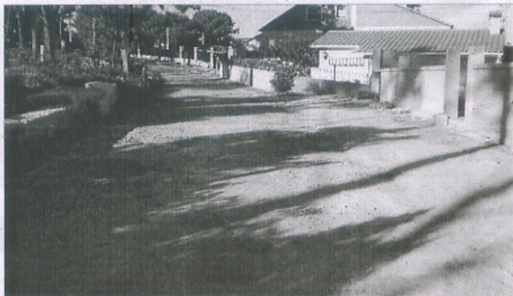
Estado en el que se encuentra el vial que da acceso a la playa de Bascuas. / AFP G. SAVIOS
